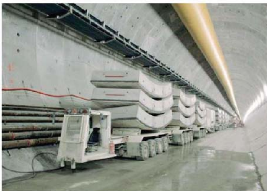
La galleria in corso di realizzazione
